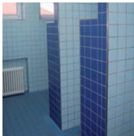
Sanitäranlagen im neuen Glanz
